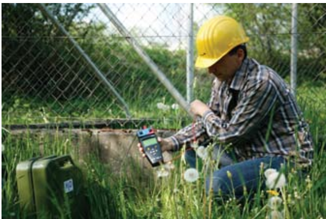
Berührungsspannungsmessung mit dem CP AL1 bei Einspeisung mit dem CPC 100 und dem CP CU1
