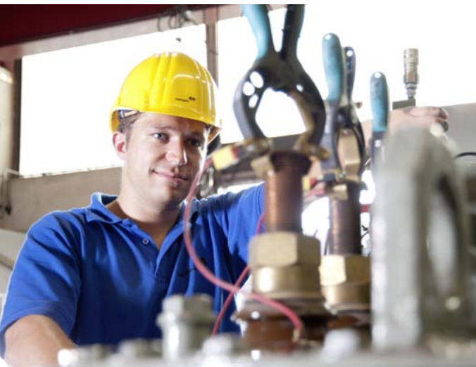
Überwachung des Trocknungsprozesses mit DRYmon
